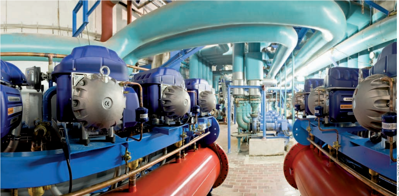
Иллюстрация 11: Две холодильных установки QUANTUM охлаждают здание компании общественного вещания WDR в городе Кельн.
