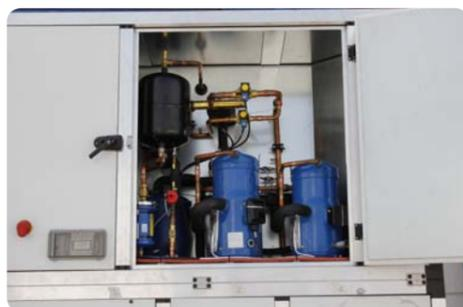
Использование компрессоров с регулируемой скоростью BLDC и электронных расширительных клапанов позволяет производить непрерывное модулирование мощности и гарантировать максимальную производительность при частичных нагрузках, с высокой степенью точности регулирования подаваемой мощности.
