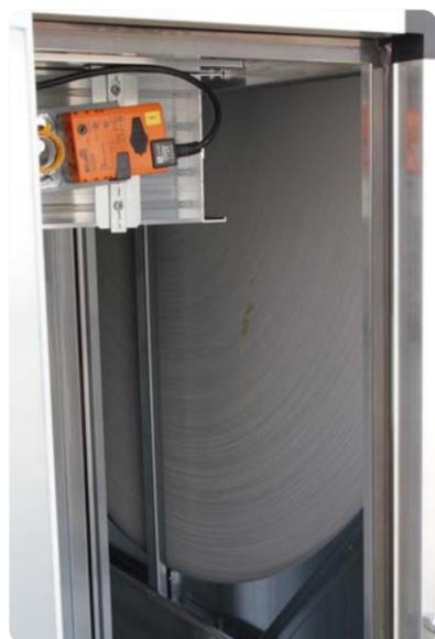
Ротационный рекуператор тепла на борту машины позволяет рекуперацию тепловой энергии от потока выходящего воздуха, уменьшая работу компрессора. Особый материал позволяет также рекуперацию как явного, так и латентного тепла, с производительностью по температуре и влажности более 80%.
